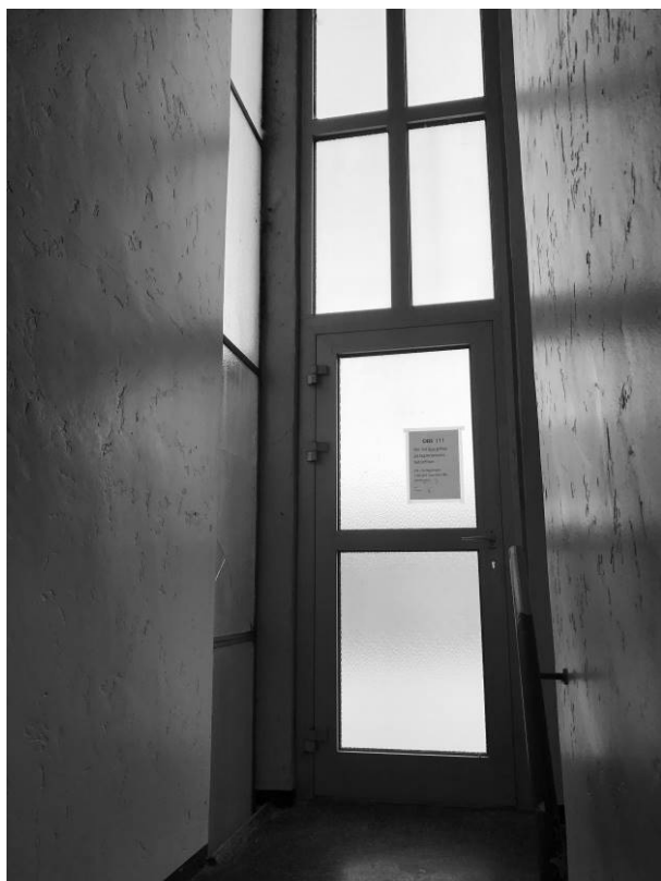
I trappeopgangen er der bevaret to originale opgangsvinduer "bag" ved villa N. Det skimtes på fotoet ovenfor til højre for døren ved det runde vindue. Der sidder ligeledes originale opgangsvinduer med enkeltlagsglas i opgang C.
