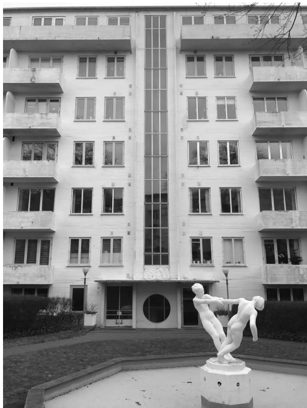
Opgang I med original dør og rundt vindue.
