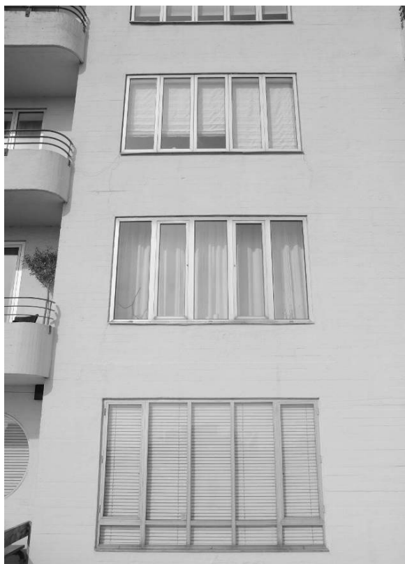
Der er flere typer alu- og træ/alu-vinduer, de fleste med udvendig ubehandlet aluminiums overflade. Th. de originale vinduer. Tværposten i bunden er udeladt i fra stueetagen opefter (balkon er parterre under stuen).
