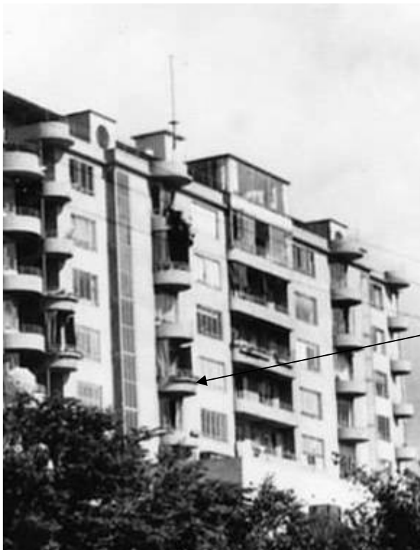
Under en del af de runde altaner er der bevaret nogle spinkle rør. Disse har sandsynligvis været anvendt til afskærmning, som det ses på fotoet fra 1940'erne (?). Bemærk i øvrigt også, at den øverste altan under vinterhaven har været inddækket. Det har ikke været muligt at konstatere farvelag på altanernes underside. På mange fotos synes undersiden at være mere end "skygge mørk". Vi ved dog med sikkerhed, at vinterhavens loft har været malet himmelblå.
