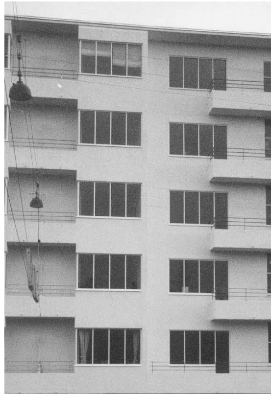
Facaden efter renoveringen med HS Hansen Millennium. Oplukspartierne er helt skjulte i partierne. Som oprindeligt.
