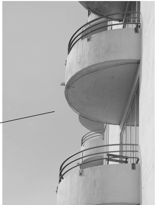
Under en del af de runde altaner er der bevaret nogle spinkle rør. Disse har sandsynligvis været anvendt til afskærmning, som det ses på fotoet fra 1940'erne (?). Bemærk i øvrigt også, at den øverste altan under vinterhaven har været inddækket. Det har ikke været muligt at konstatere farvelag på altanernes underside. På mange fotos synes undersiden at være mere end "skygge mørk". Vi ved dog med sikkerhed, at vinterhavens loft har været malet himmelblå.
