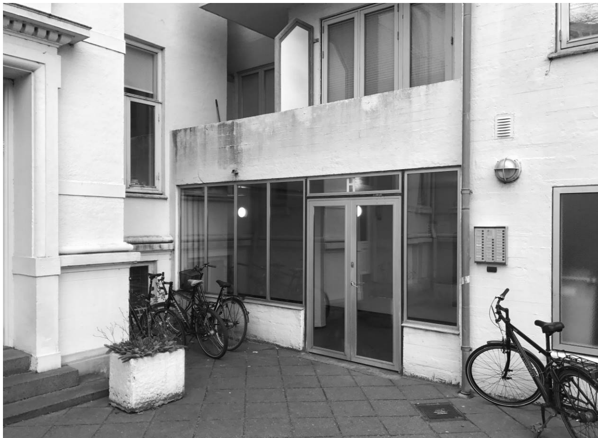
Opgang H, gårdsiden af blok 4. 2017.
