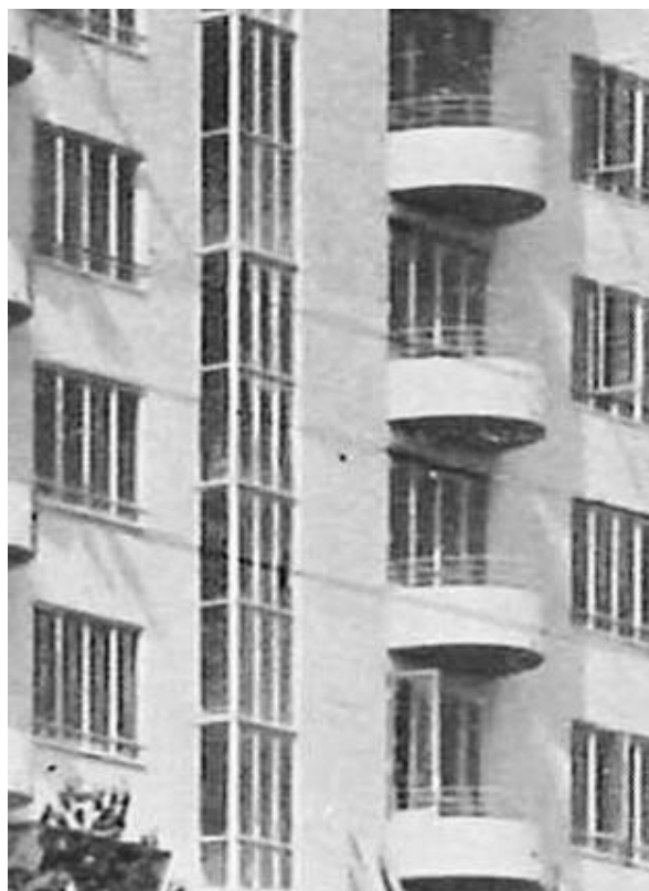
Der er flere typer alu- og træ/alu-vinduer, de fleste med udvendig ubehandlet aluminiums overflade. Th. de originale vinduer. Tværposten i bunden er udeladt i fra stueetagen opefter (balkon er parterre under stuen).
