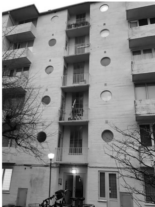
Opgang C med originale opgangsvinduer.
